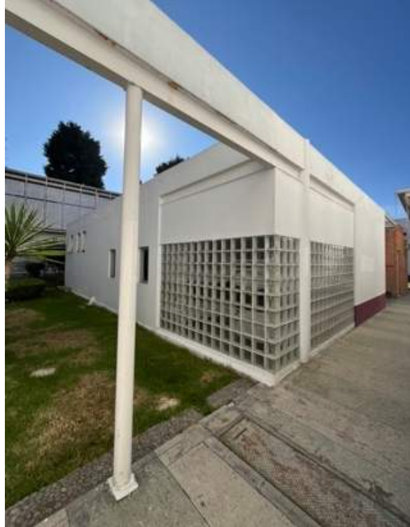
Imagen 8. Vista exterior de área de medianos desde sala de TV.
